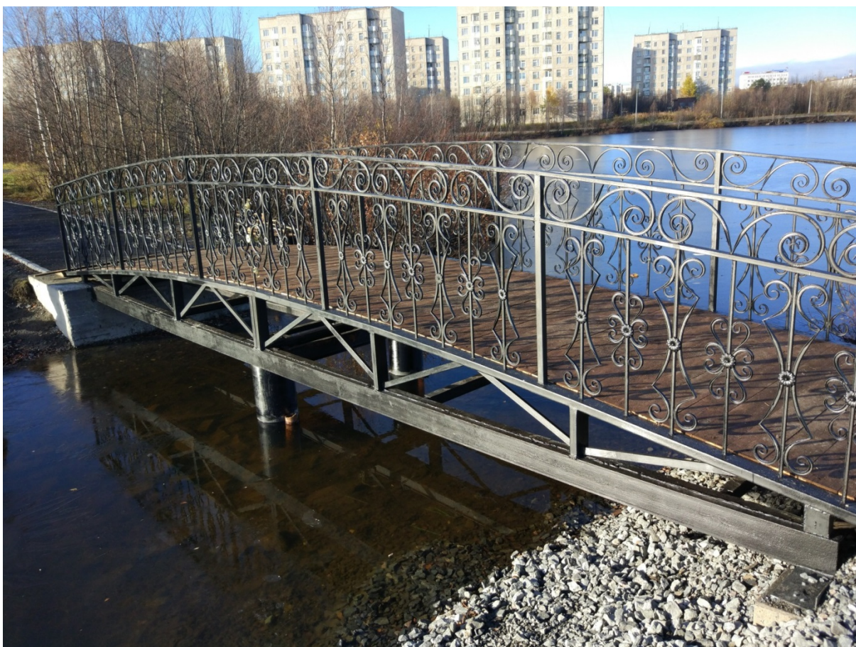
Уложен огрунтованный деревянный настил мостика, работы завершены.
