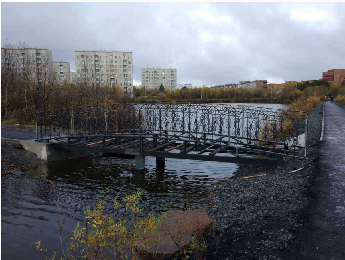
Выполнены работы по окраске металлоконструкций мостика
